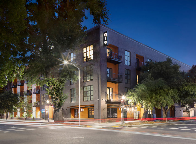
Q19 PROJECT IN SACRAMENTO
